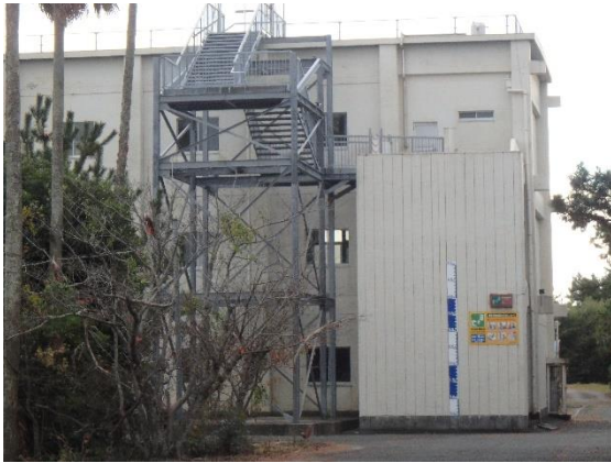
写真-1 津波避難タワー（民間会社）
