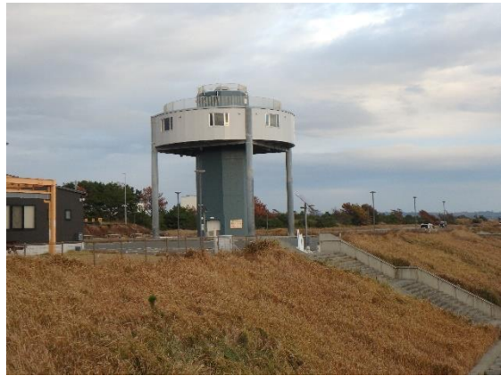
写真-2 津波避難タワー（福田漁港）
