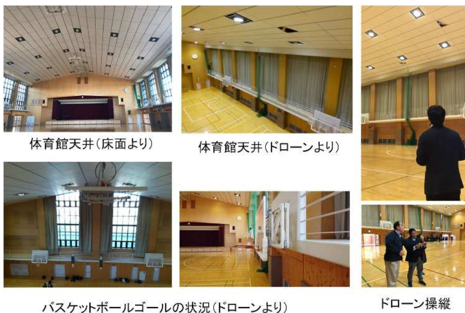
図9 ドローンによる体育館天井調査の様子
