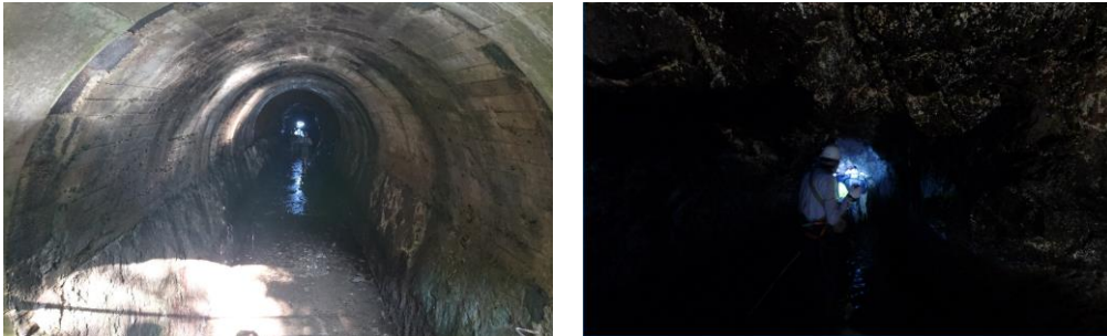
図1 深良用水隧道点検の様子（左：入口付近，右：内部の様子）
