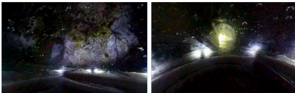
図4 深良用水隧道内の様子
