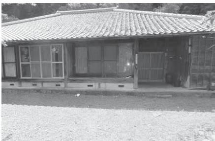
合宿した西田正鋭氏宅：大正期に建築、平屋60坪ほど、(6部屋+DK+土間+風呂など)、数年前から空き家
